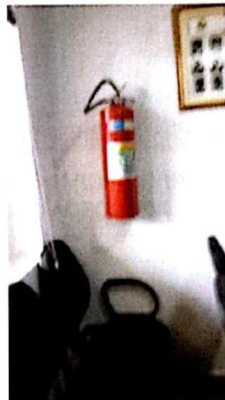
FOTO 03 E 04: EXTINTORES VENCIDOS; EM LOCAL E INSTALAÇÃO INADEQUADAS.
