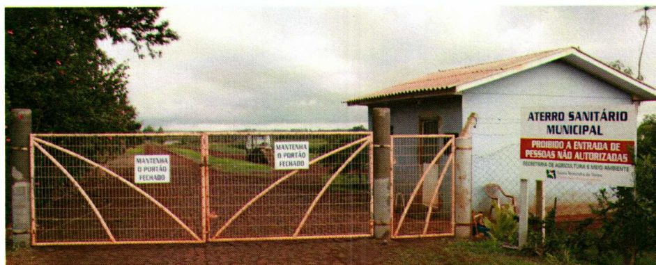
Figura 63 – Portão de acesso do aterro sanitário de Santa Terezinha de Itaipu.
