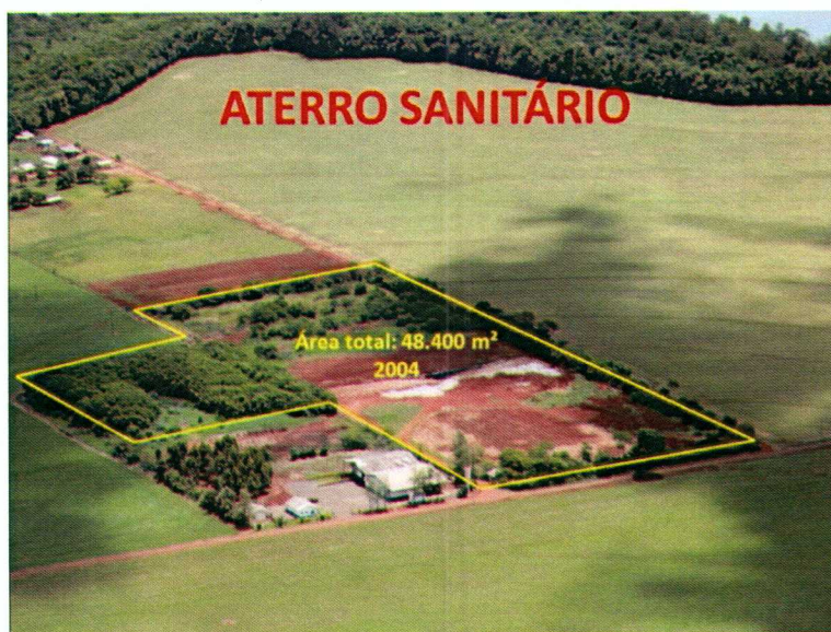
Figura 57 – Foto aérea da área do aterro sanitário.
