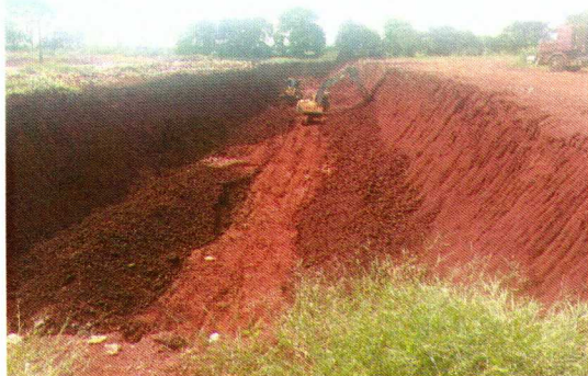
Abertura de valas
