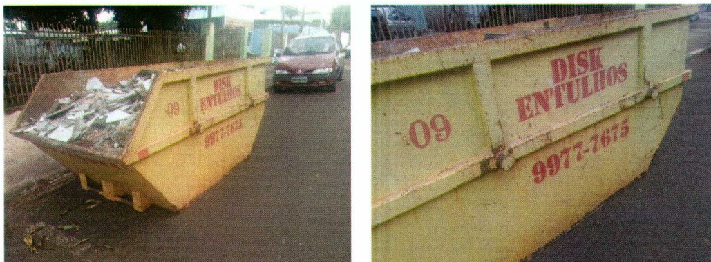
Figura 76– Acondicionamento dos resíduos da construção civil.
