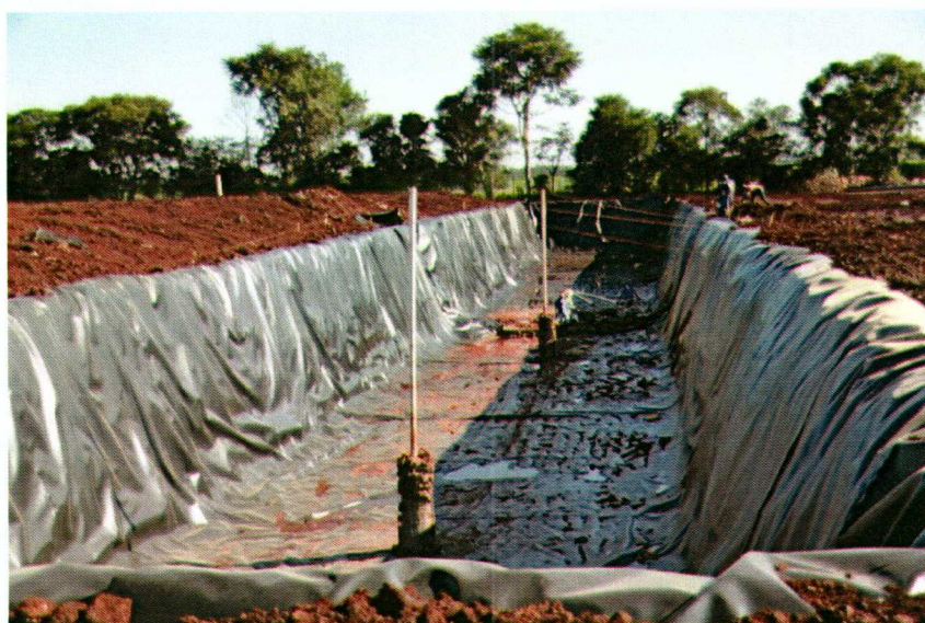
Figura 59 – Sistema de Drenagem de Gases de Exaustão.
