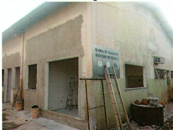
Figura 52 – Central de Tratamento de Materiais Recicláveis em Obras.
