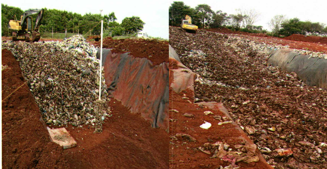
Figura 61 – Disposição dos resíduos sólidos nas trincheiras e compactação.
